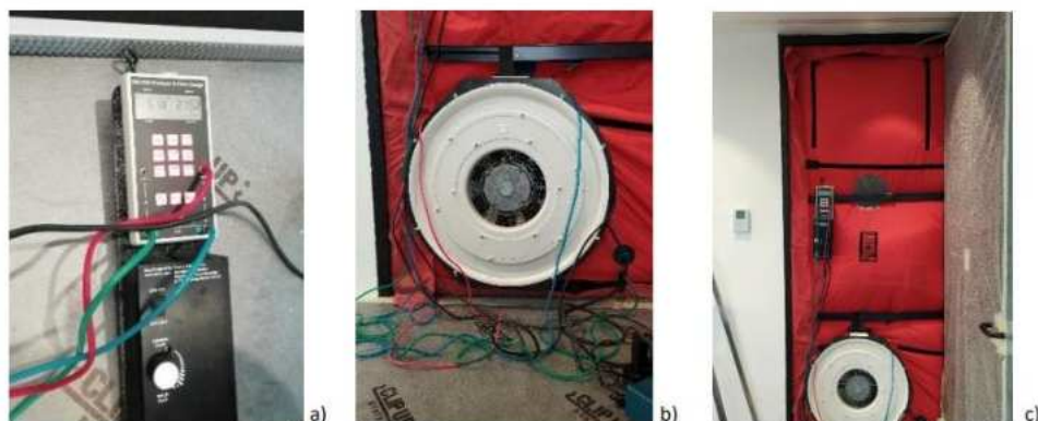
Fig. 5.11 – Esempio di misura della permeabilità mediante blower door test in un edificio residenziale. a) manometro b) ventilatore c) telaio ermetico
