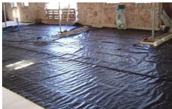
Fig. 5.52 - Esempi di posa di barriera protettiva
